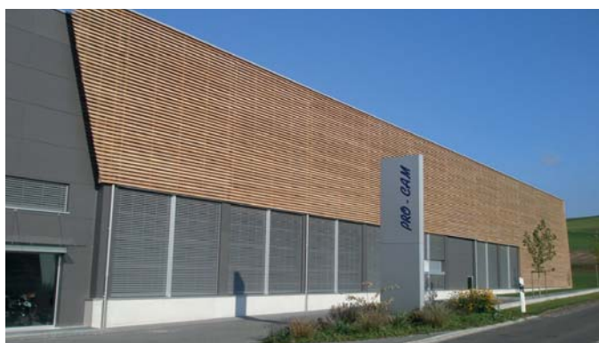
Neubau Produktionshalle Huttwil / Minergie
