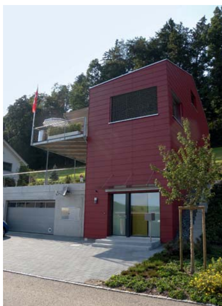
Neubau Einfamilienhaus Ohmstal / Minergie P
